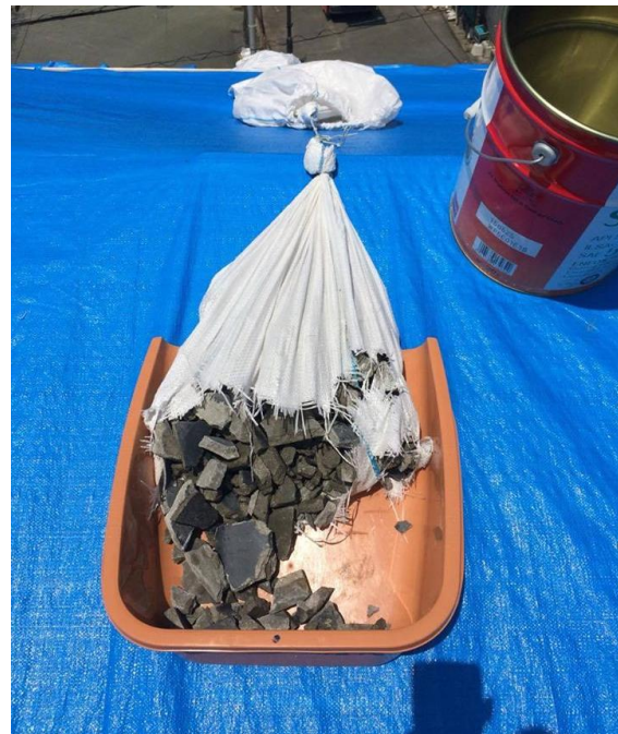
敗れた土嚢等、落下危険物の除去等
