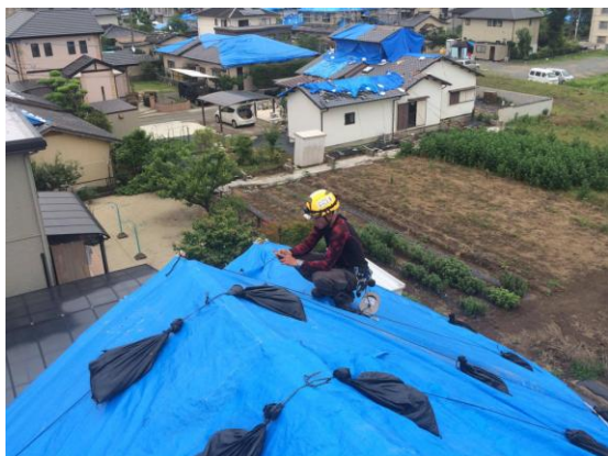
屋根の応急処置作業
