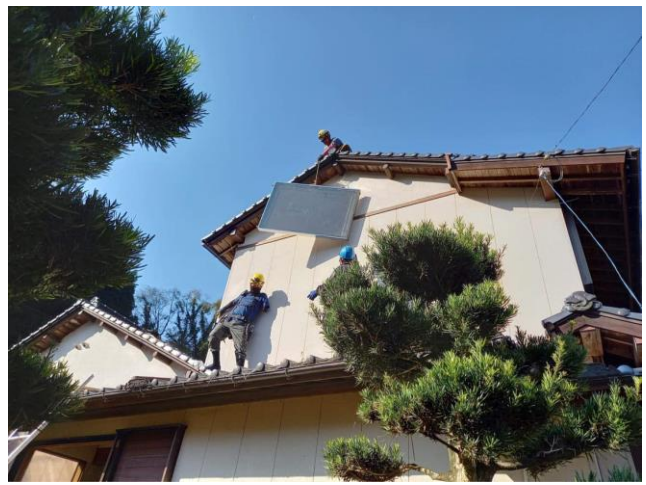
(給湯器の取外し 11/11)
