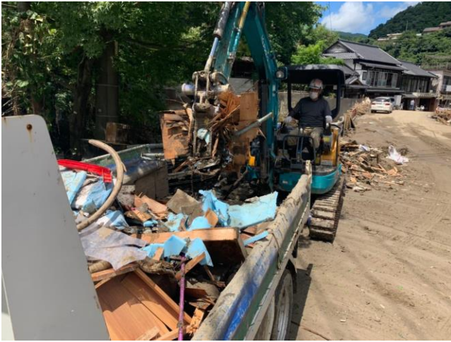
(重機・ダンプの活用 7/20)
