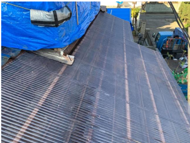
(波板等を活用した修繕)
