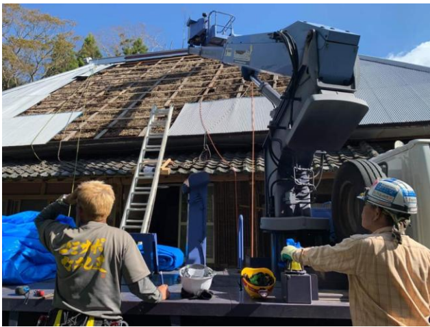
(茅葺屋根への対応と高所作業車の活用)
