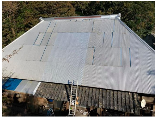
(茅葺屋根の修繕後)
