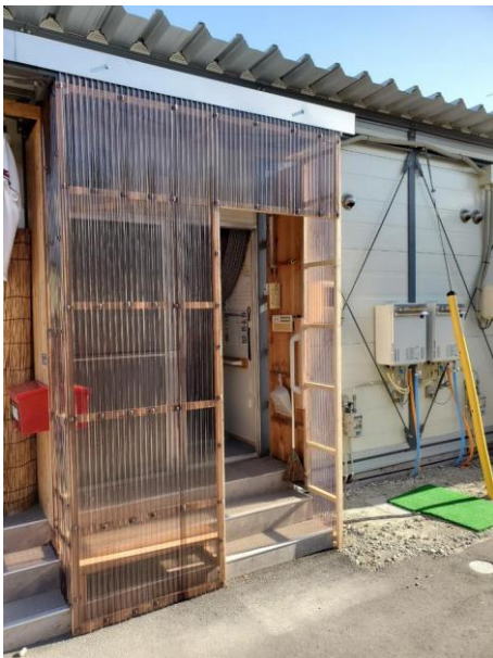
(完成した風除け室)
