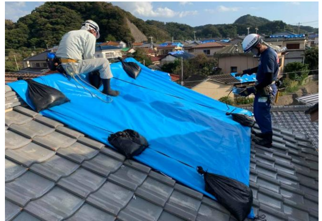
屋根の応急処置（シートの養生）
