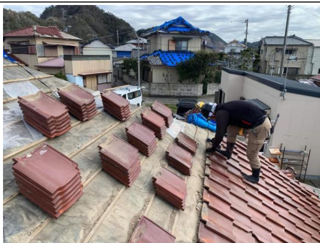
瓦の差しかえによる養生面積の削減
