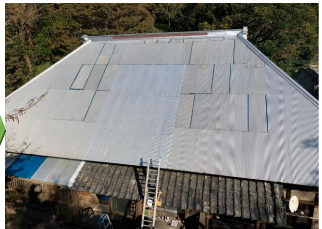
剥がれたトタンの張直し後
