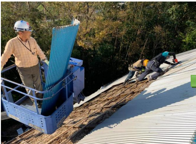
高所作業車の活用とトタンの張り直し
